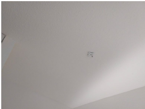
Détecteur de fumée
